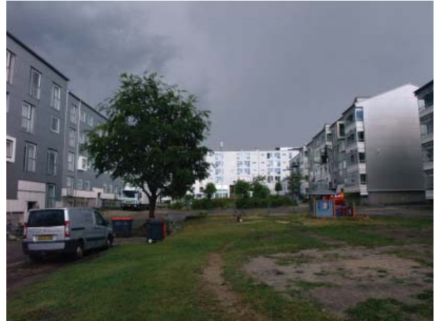
Egedalsvænge i gang med en større fornyelsesproces, hvor hele boligområdet på registreringstidspunktet er under ombygning og facaderenovering.
