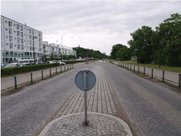
Holmegårdsvej, kig mod syd.
