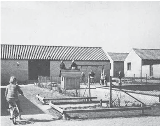
Legeplads i Nivåvænge umiddelbart efter opførelse af bebyggelsen i 1966.
