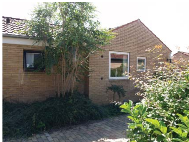
Eksempel på udskiftning af vinduer til nyere vinduestyper i en anden farve og dimensionering af vinduesrammer.
