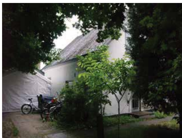
Det sydvestligste hus syd for Nivå Station skjæmmes af beplantning, så den tydelige sammenhæng i bebyggelsen fra århundredskiftet sløres.
