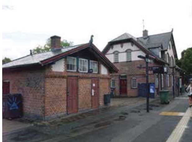
Nivå Station set fra nordvest.
