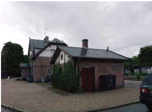
Nivå Station set fra nordøst. Stationsbygning og toilethus har sammen med tjenesteboligerne klare nationalromantiske træk.
