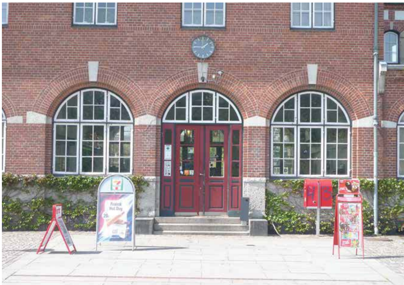
Humblebæk Station fra 1897 er et fornemt eksempel på tidens stationsarkitektur og fremstår fuldstændig velbevaret.
