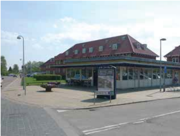
Tilbygninger og facadeændringer kan sløre den ellers meget sammenhængende arkitektur og materialeholdning.
